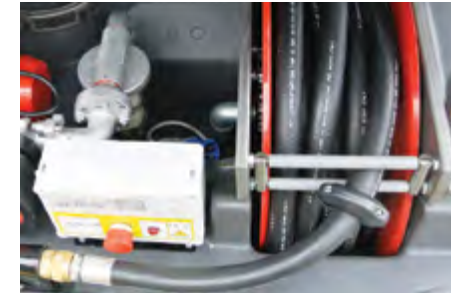
Cuadro eléctrico y enrollador de manguera. Placa de interruptores elétricos e carretel da mangueira.
